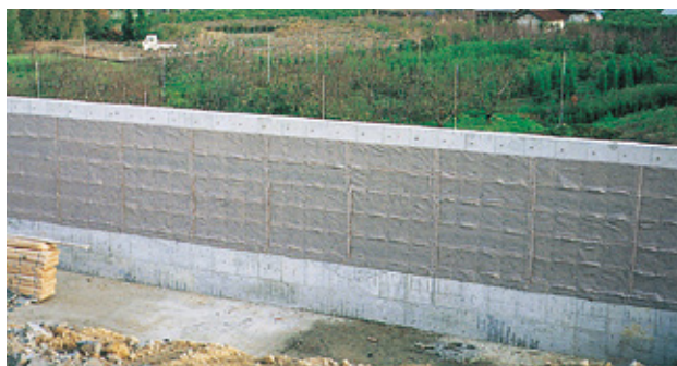
■ 住宅地造成地のL型擁壁に、横貼りで施工
