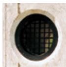
透水マットの保護工 (水抜穴保護用ネットの取付け)
