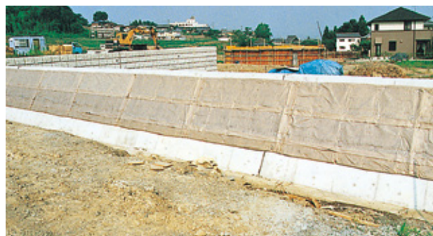
■ 住宅地造成地の重量式擁壁に、横貼りで施工
