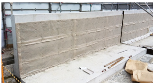
■ 分譲マンション開発地のL型擁壁に、横貼りで施工
