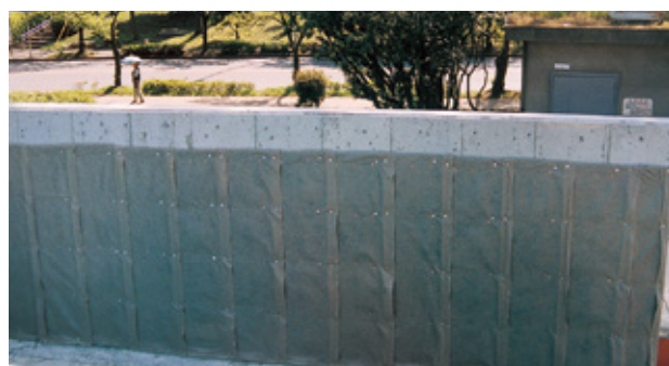
■ 住宅地造成地のL型擁壁に、縦貼りで施工
